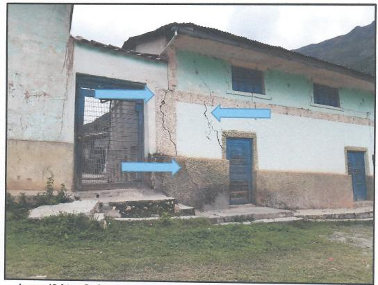
Imagen 15: fotografía, fisuras en vivienda de cuenca producido por Deslizamiento de tierra, ubicado aproximadamente a 20 m.
