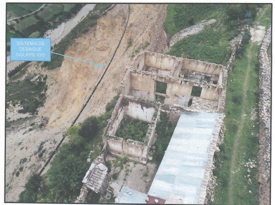
Imagen 13: fotografía aérea (Drone), viviendas afectadas por el deslizamiento de tierra ocurridos años atrás y el sistema de Desagüe colapsado por el Deslizamiento.
