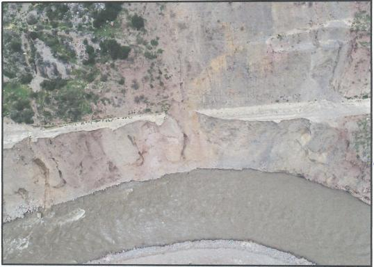
Imagen 17: fotografía aérea (Drone), Colapso y perdida de Plataforma de la vía férrea y socavamiento de Talud por las aguas del Rio Mantaro ya que originaría un posible Deslizamiento.
