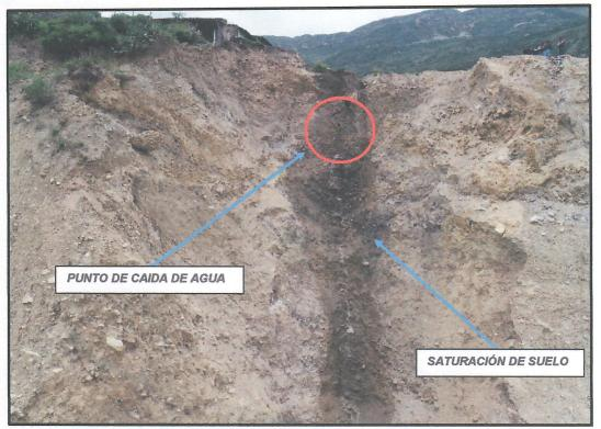
**Imagen 05**: fotografía aérea (Drone) Socavamiento y Saturación de suelo por las aguas Pluviales y Residuales exponiendo al peligro "Deslizamiento" a la población de cuenca, carretera y Vía Ferrea". **Fuente:** Grupo técnico GRD.
