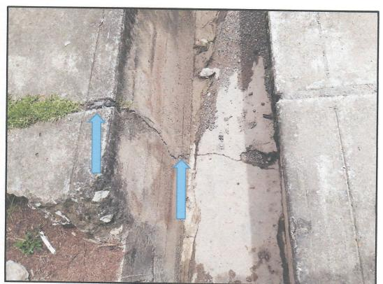
Imagen 16: fotografía, fisuras en piso ciudad de cuenca producido por el deslizamiento de tierra, ubicado aproximadamente a 50 m.
