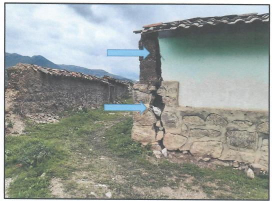
Imagen 12: fotografía aérea (Drone), fisuras y agrietamiento en las viviendas afectadas por el deslizamiento de tierra "movimiento en masa" ocurrido año atrás.
