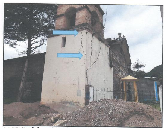
Imagen 14: fotografía, fisuras en la iglesia de cuenca producido por el deslizamiento de tierra, ubicado a 80
