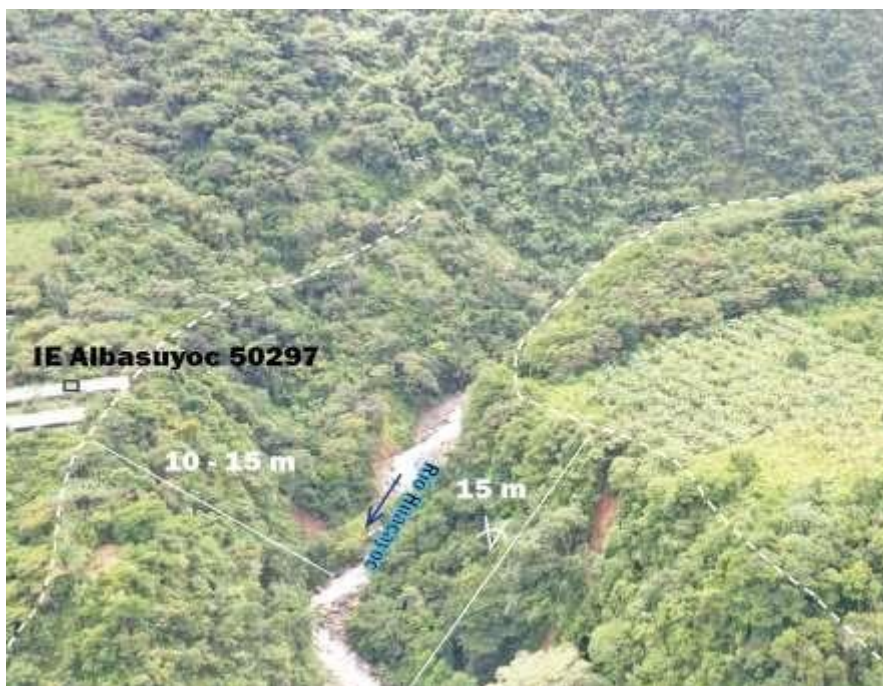
Fotografía 10. Vista de laderas empinadas a ambos flancos del río Huacayoc. Después del flujo de detritos de 2021, La I.E. Albasuyoc 50297 se encuentra a pocos metros del flanco derecho del río
