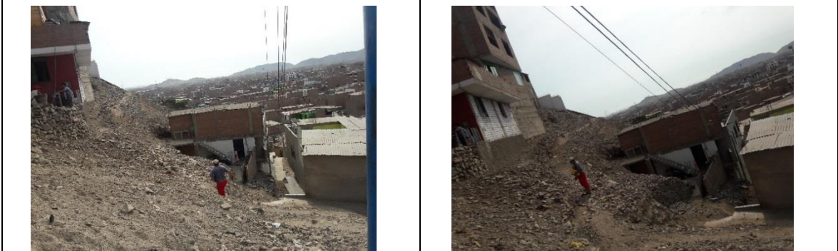
Se observa la falta de muros de contención en los pasajes de circulación y entre lotes en vista de presentar pircas con taludes inestables.
