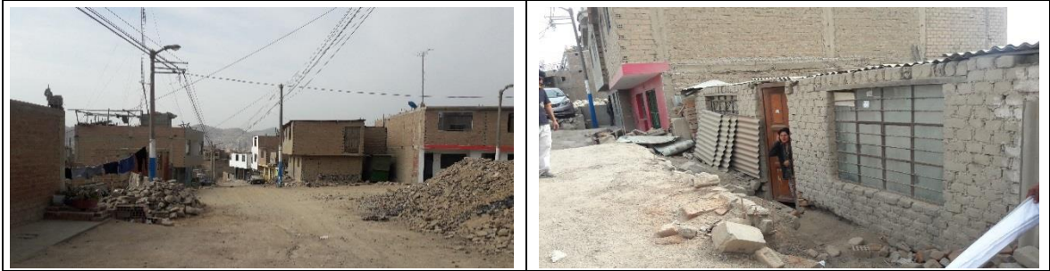
Se observan en el AA. HH. 03 de Mayo, con edificaciones de (madera en un 20 % y 80 % de albañilería confinada) aprox. Sin la adecuada asesoría profesional solo por autoconstrucción.
