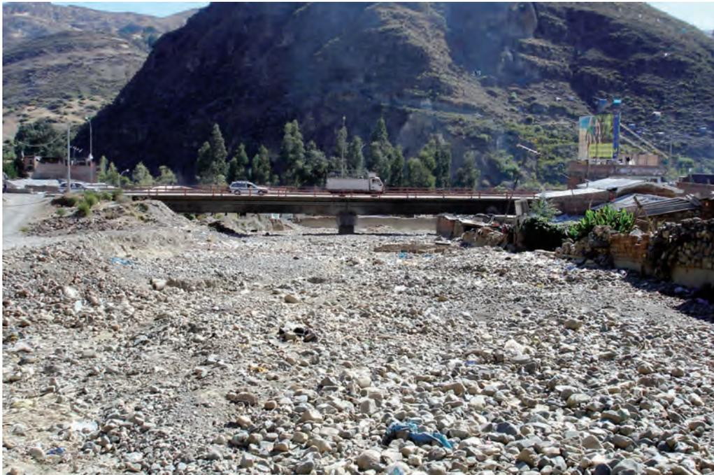
Fotografía 77 El puente que es el nexo de la ciudad de Huaraz con Recuay, Conococha y Lima, se ve muy afectado por los depósitos de flujos de detritos.
