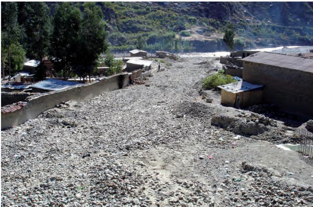
Fotografía 76 Vista al detalle de las viviendas que se encuentran en los cauces de río Seco y los depósitos de flujos de detritos que discurren anualmente por esta quebrada.
