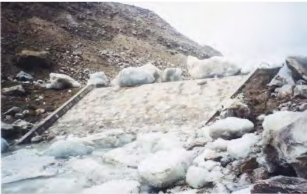
Fotografía 34 Estado de los diques artificiales de regulación de caudal después del evento del 2003, los bloques de hielo fueron traídos por las olas de tsunami en el lago. (Fotografía INRENA, 2003).
