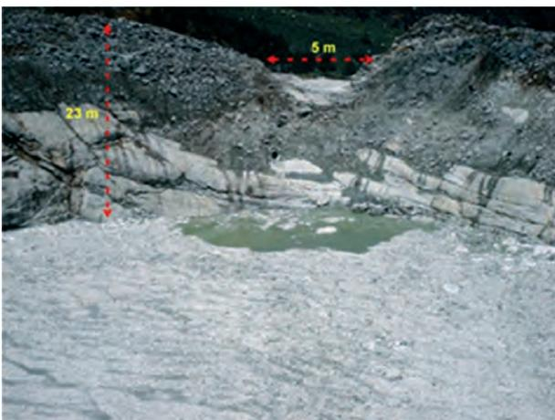
**Figura 3:** Vista de la parte frontal del vaso, nótese el borde de seguridad de la laguna de 23 metros. La erosión producida por el flujo al salir de la cubeta fue de 5 metros en la morrena.
