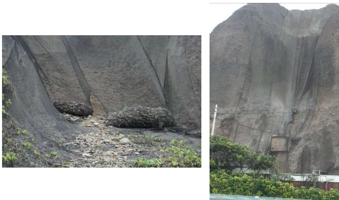
Figura 55. Vistas de rocas suspendidas en media ladera de los acantilados
