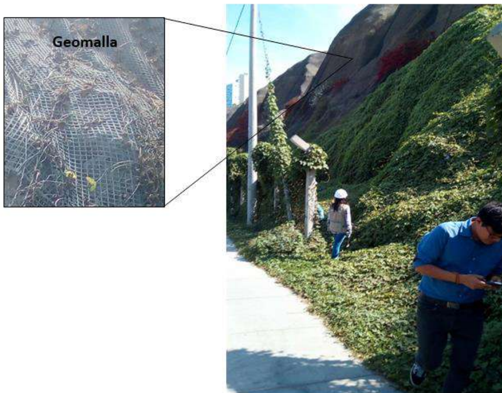
Figura 30. Geomalla recubre el acantilado en el distrito de Miraflores.
