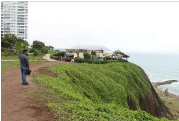
Figura 44. Vista de la parte alta del acantilado sin cerco de seguridad
