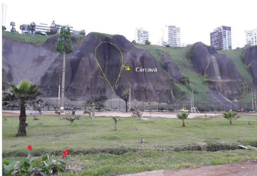
Figura 25. Cárcava en el acantilado de la Costa Verde - Miraflores.
