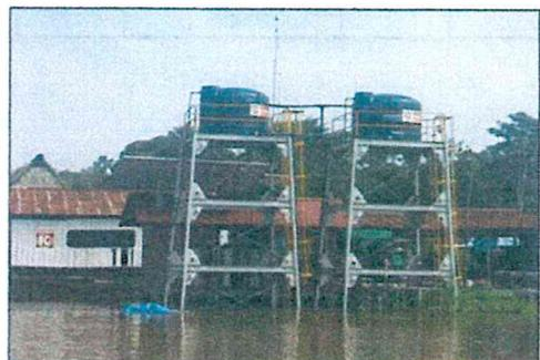
Tanque de agua (obra sin concluir) afectadas por la inundacion y con notables adaptaciones para sobrelevaeria
