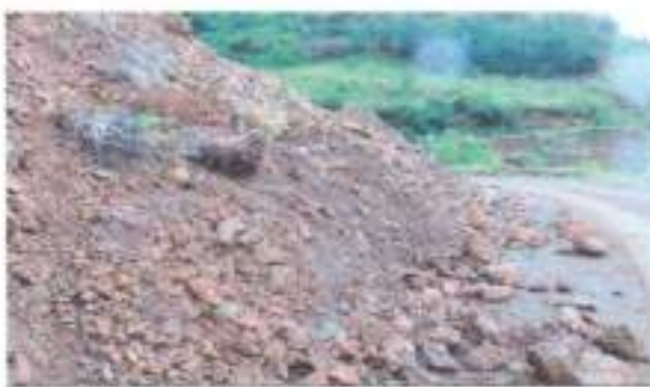
Figura N°12. Deslizamiento de terreno en carretera
