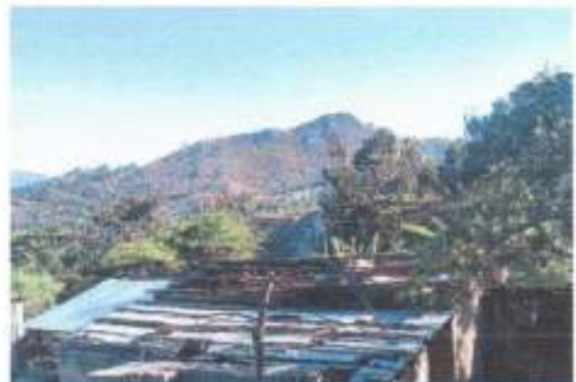
Figura N° 14. Levantamiento del techo por fuertes vientos
