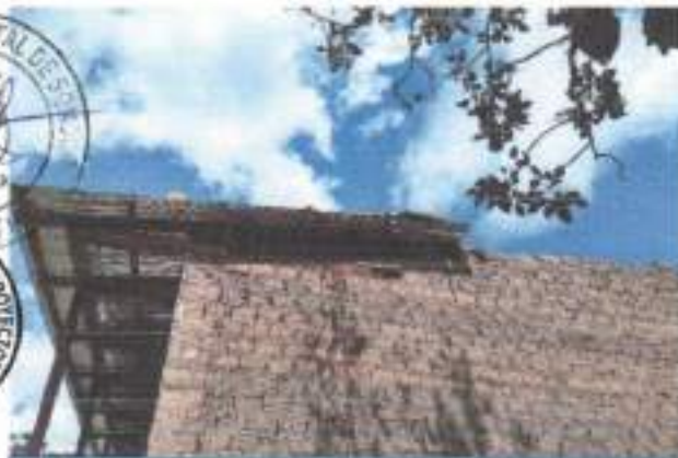
Figura N° 13. Levantamiento del techo por fuertes vientos
